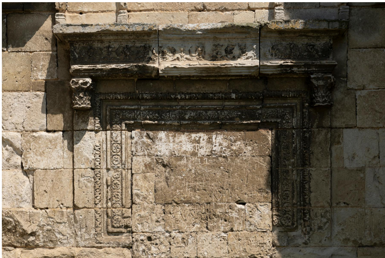
Détail du portail Renaissance, élévation sud.
