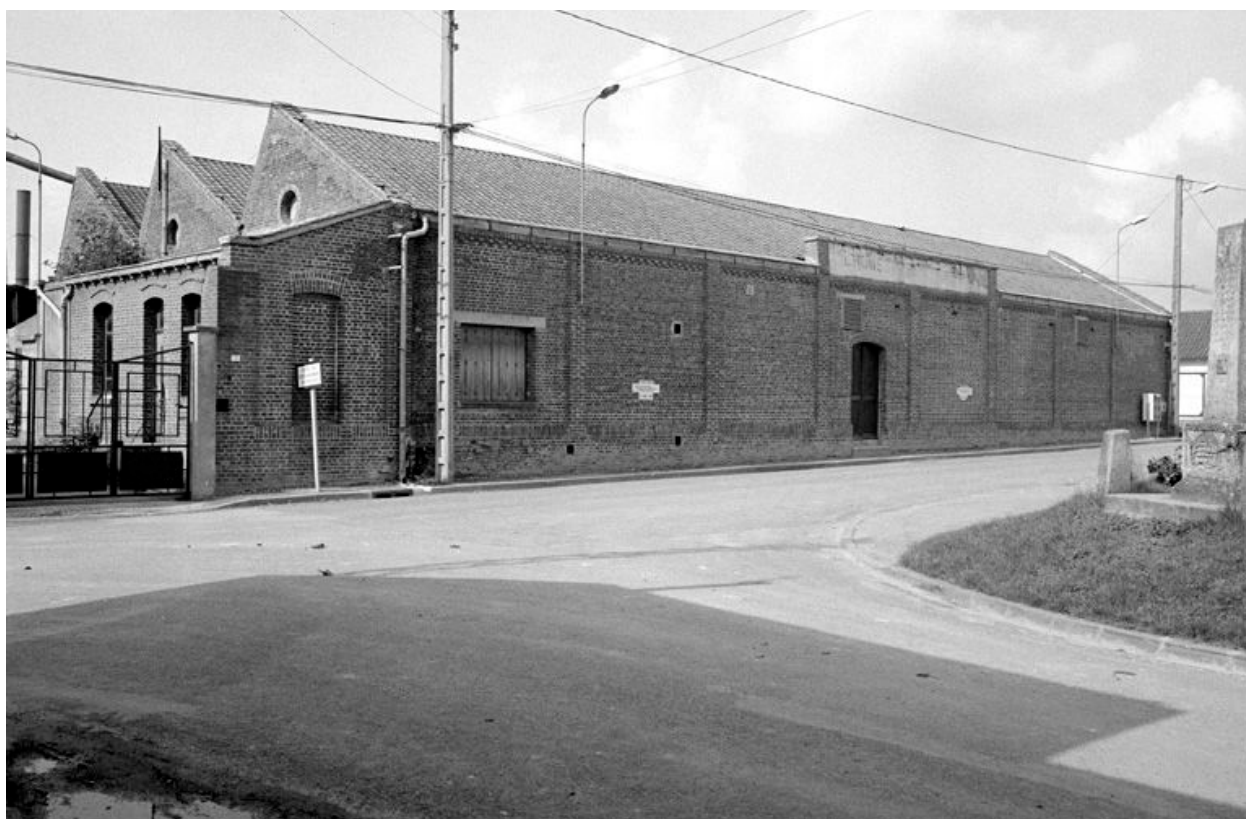
Ateliers de fabrication de l'ancienne usine, élévation antérieure.
