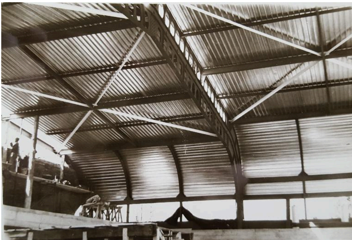
Détail de l'intérieur de la structure mobile. Vue de chantier. Juillet 1967. Photo : Société MacGregor-Comarain (AN ; 19840036/145).
