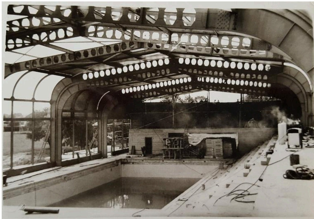
Vue de l'intérieur de la piscine à la fin des travaux. Juillet 1967. Photo : Société MacGregor-Comarain (AN ; 19840036/145).
