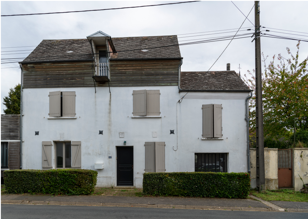
Ancienne boulangerie, n°20 de la rue d'en-Haut, vue depuis l'ouest.
