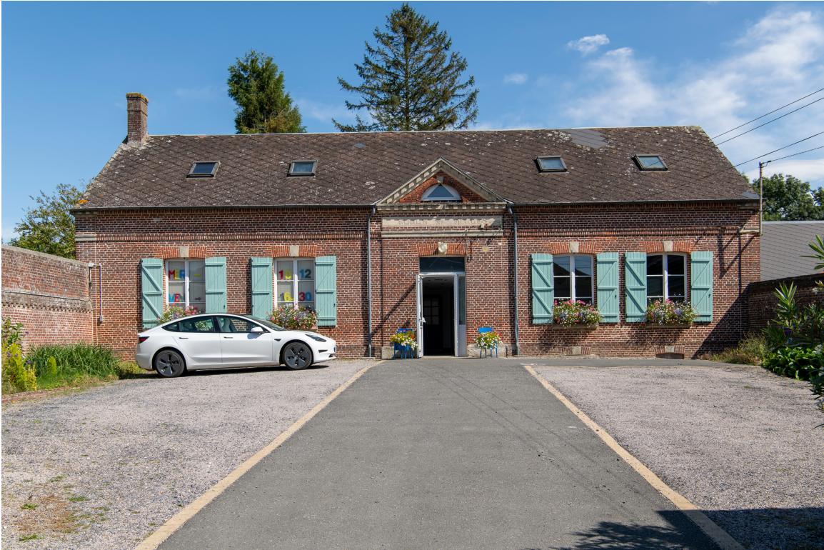
Ancienne école de filles, aujourd'hui bibliothèque, rue Henri-Sohier, vue depuis l'ouest.
