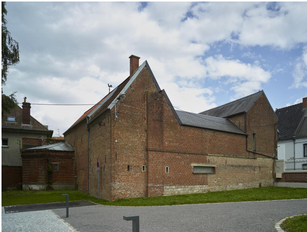
Façade latérale gauche depuis la cour du n°18, rue Carlier. Vue orientée sud-ouest/nord-est.
