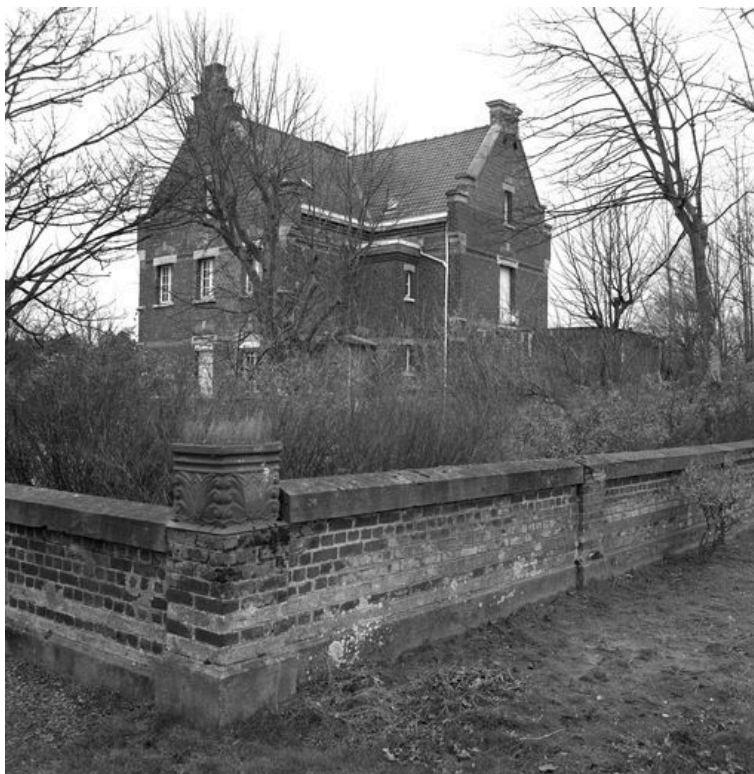
Habitation du directeur, élévation postérieure, vue générale prise de trois quarts gauche avec le mur de clôture du jardin au premier plan.
