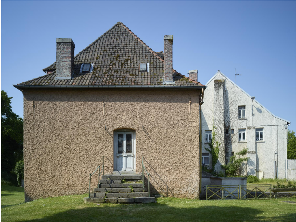
Caserne Cernay : murs pignon est des deux ailes (à gauche, aile ouest, à droite aile est). Vue orientée est - ouest.
