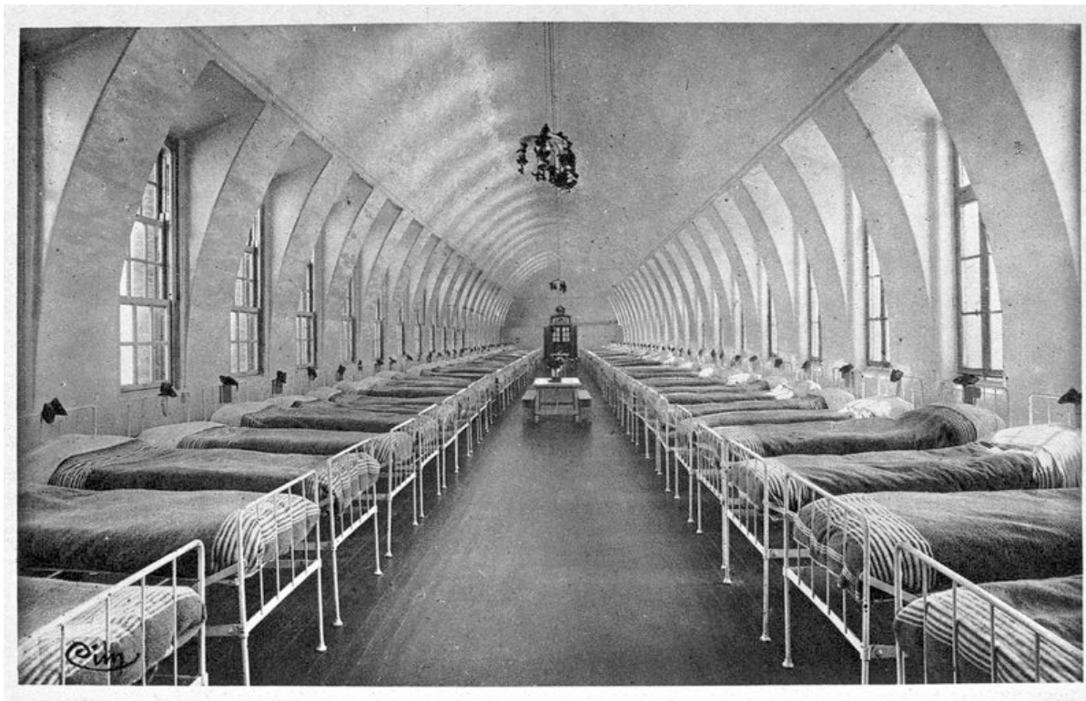
Un des pavillons des enfants valides, intérieur d'un dortoir, vue générale prise en enfilade, photographie ancienne (archives de l'établissement).
