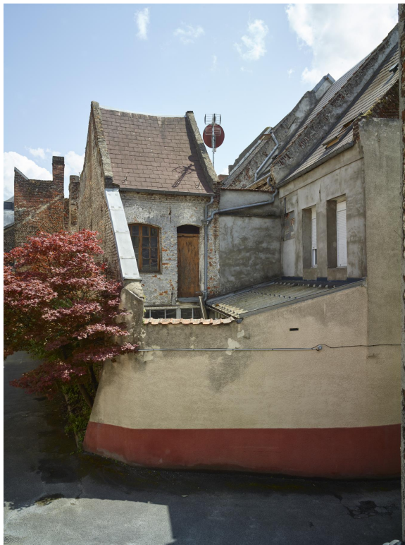
Ancienne cuisine associée au bâtiment 16, rue Gambetta. Vue depuis la cour, orientée nord/sud.
