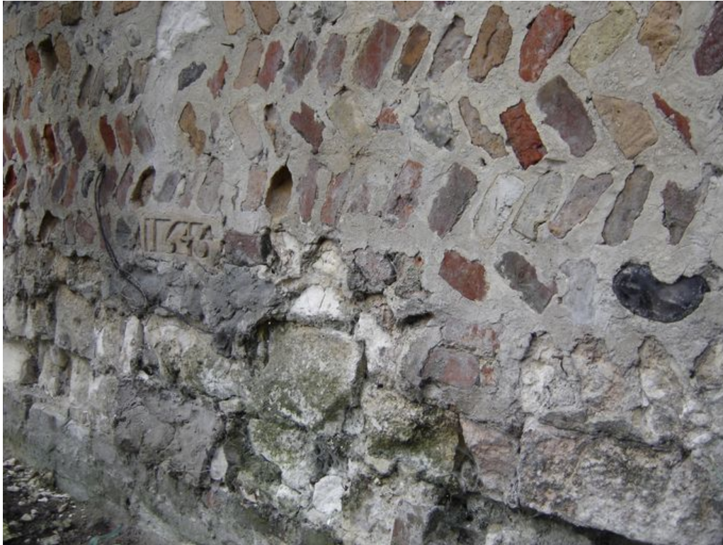
Vue partielle du mur de clôture du jardin avec cartouche incrusté portant la date de 1646.
