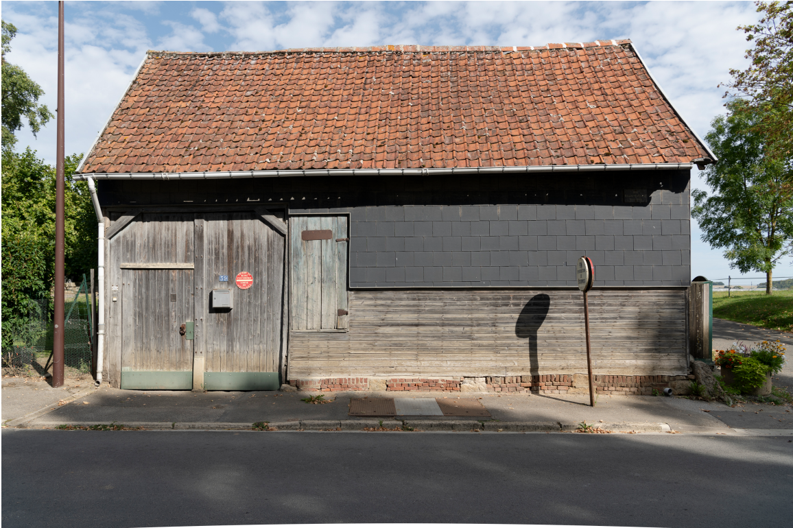
Grange sur rue, n°59 de la rue Roland-Mariage, vue prise depuis le nord.
