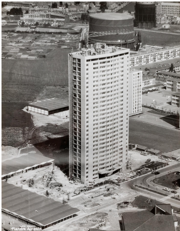
Vue aérienne de la tour Kennedy, depuis le sud-est, pendant sa construction, le 10 juin 1969 (AC Loos-les-Lille ; non coté).
