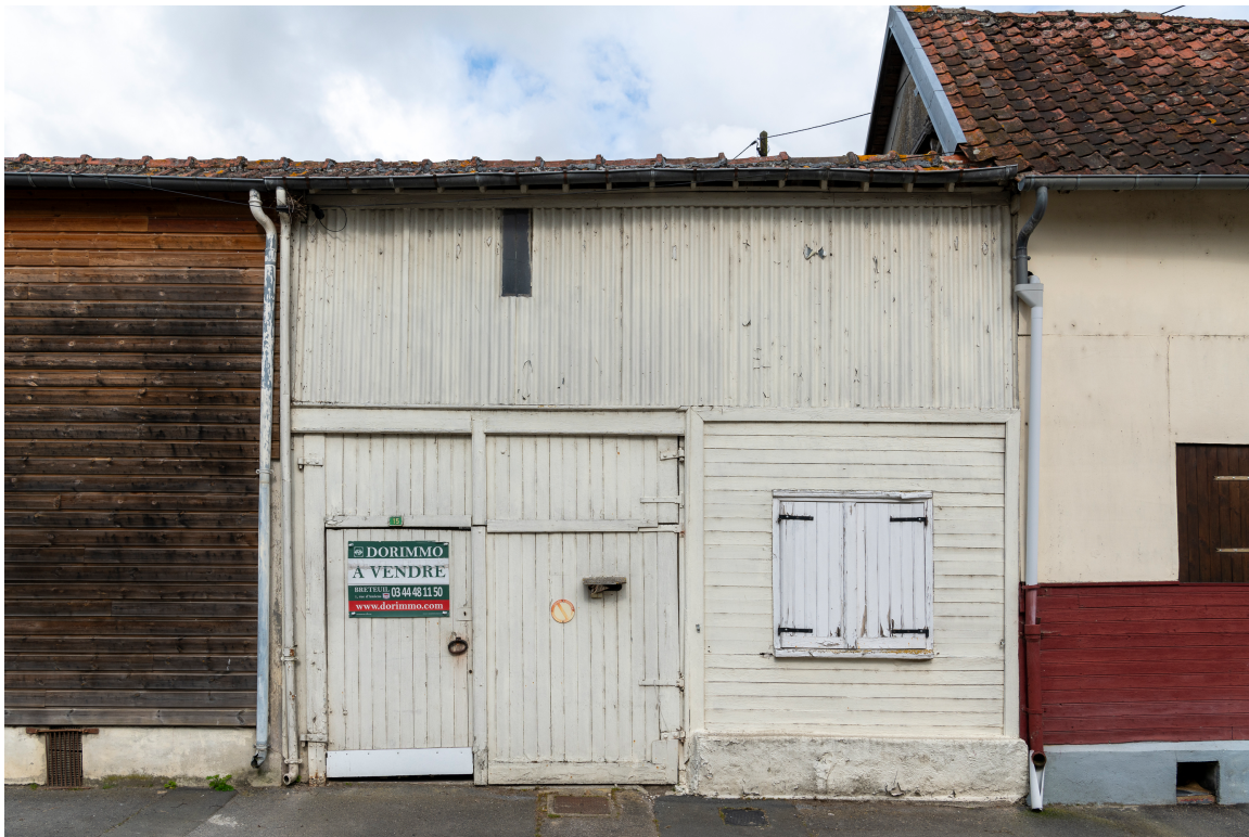
"Boutique" et entrée charretière, n°15 de la rue Thiaux, vue depuis le sud-est.
