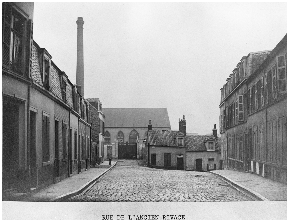
Vue de la rue de l'Ancien Rivage vers 1900. A.C. Boulogne-sur-Mer, clichés vers 1900.
