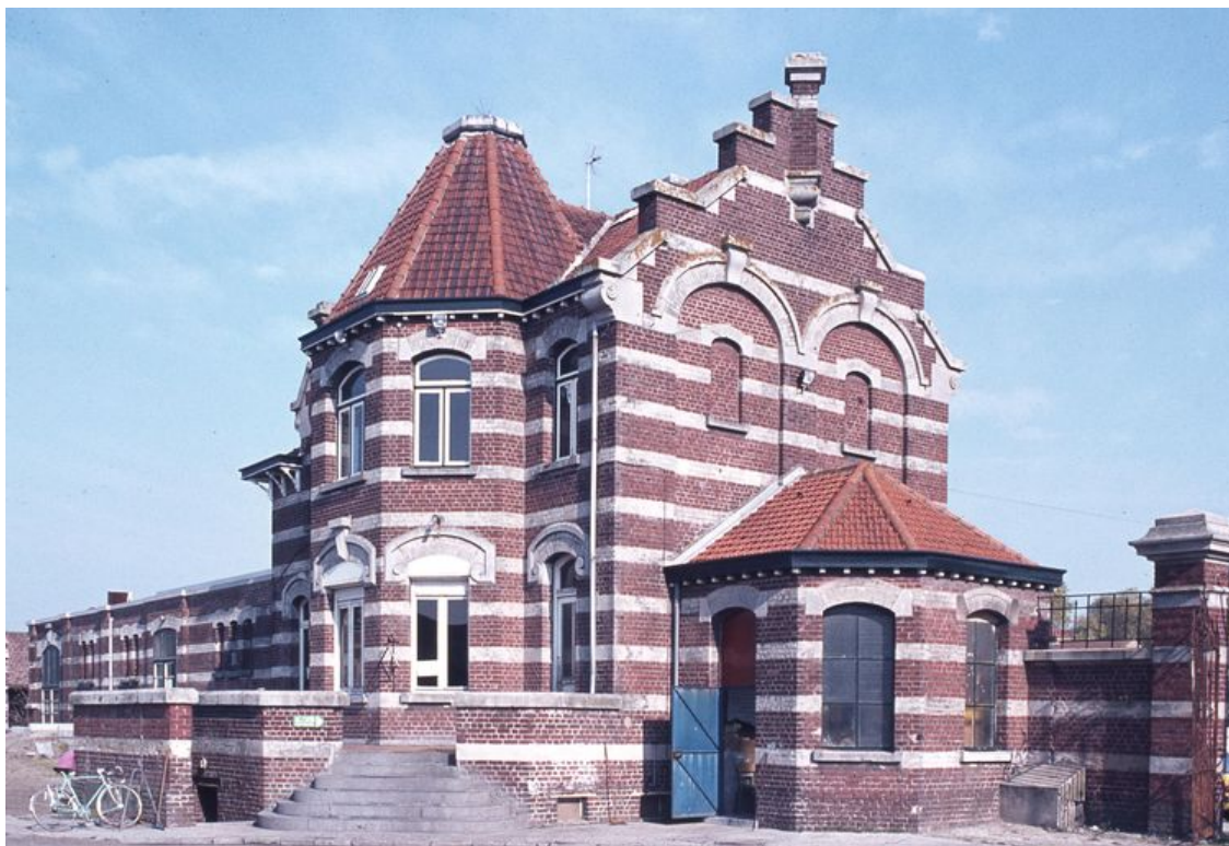
Ferme nord, bâtiments fermant la cour du côté est, détail de l'habitation du fermier, élévation sur la cour, vue de trois quarts droit.
