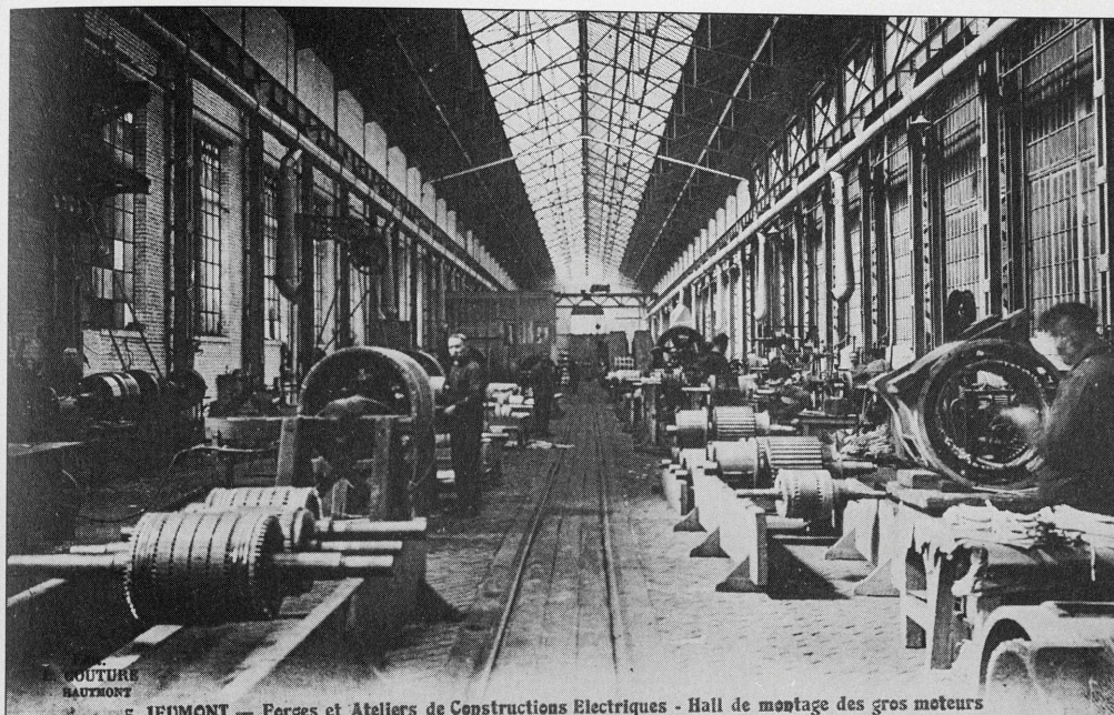
5. JEUMONT — Forges et Ateliers de Constructions Electriques - Hall de montage des gros moteurs Les moteurs fabriqués et assemblés par un personnel hautement qualifié étaient ensuite soumis à un contrôle sévère avant leur expédition.
