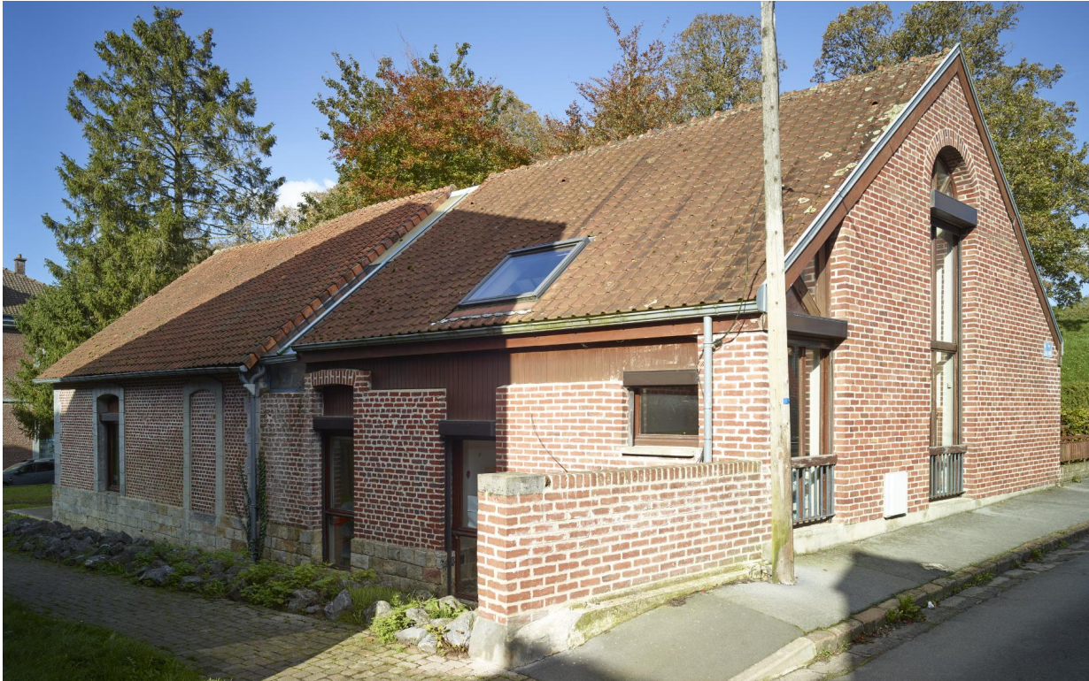
Ancienne cuisine de la caserne Lowendal, actuellement bibliothèque municipale : façade arrière et façade latérale ouest, vue orientée sud-est/nord-ouest.
