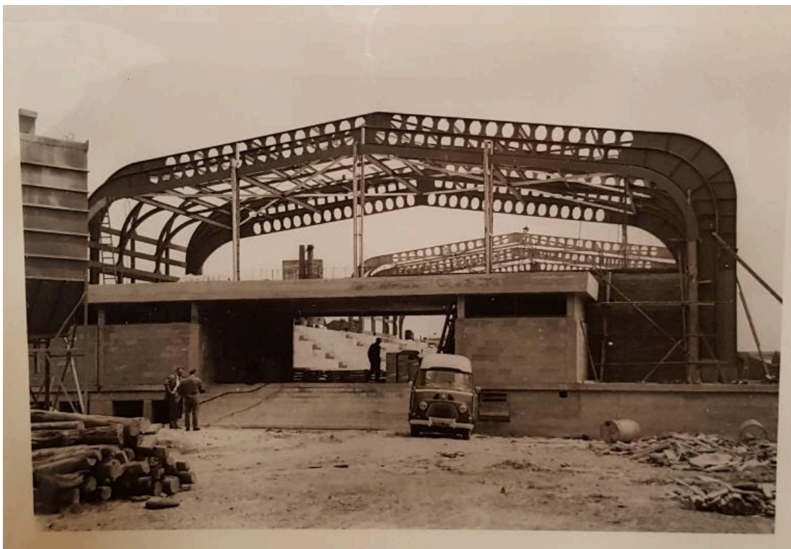
Photo de la piscine en construction, vue sur l'entrée, côté ouest, juin 1967. Photo : Société MacGregor-Comarain (AN ; 19940528/1).
