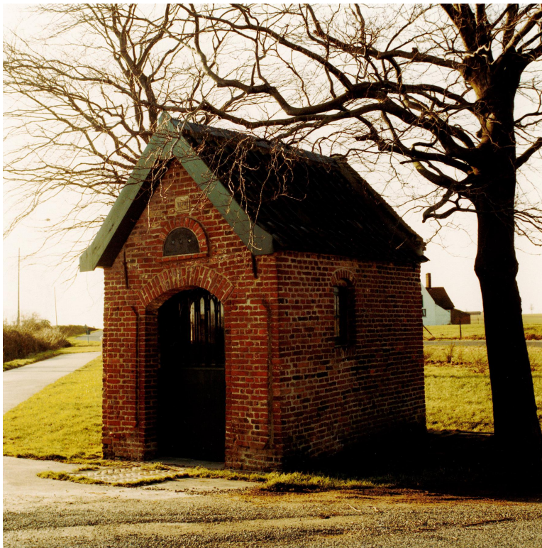
Vue nord-est de la chapelle. Restauration du Comité de Sauvegarde des chapelles de Flandre, 1979 (coll. Comité Flamand de France).
