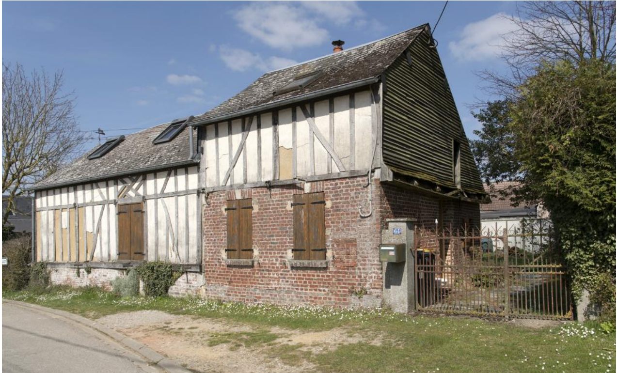
Logis sur rue avec traitement ornemental du pan de bois au-dessus d'une baie, n°64 rue Principale, vue depuis le sud-ouest.
