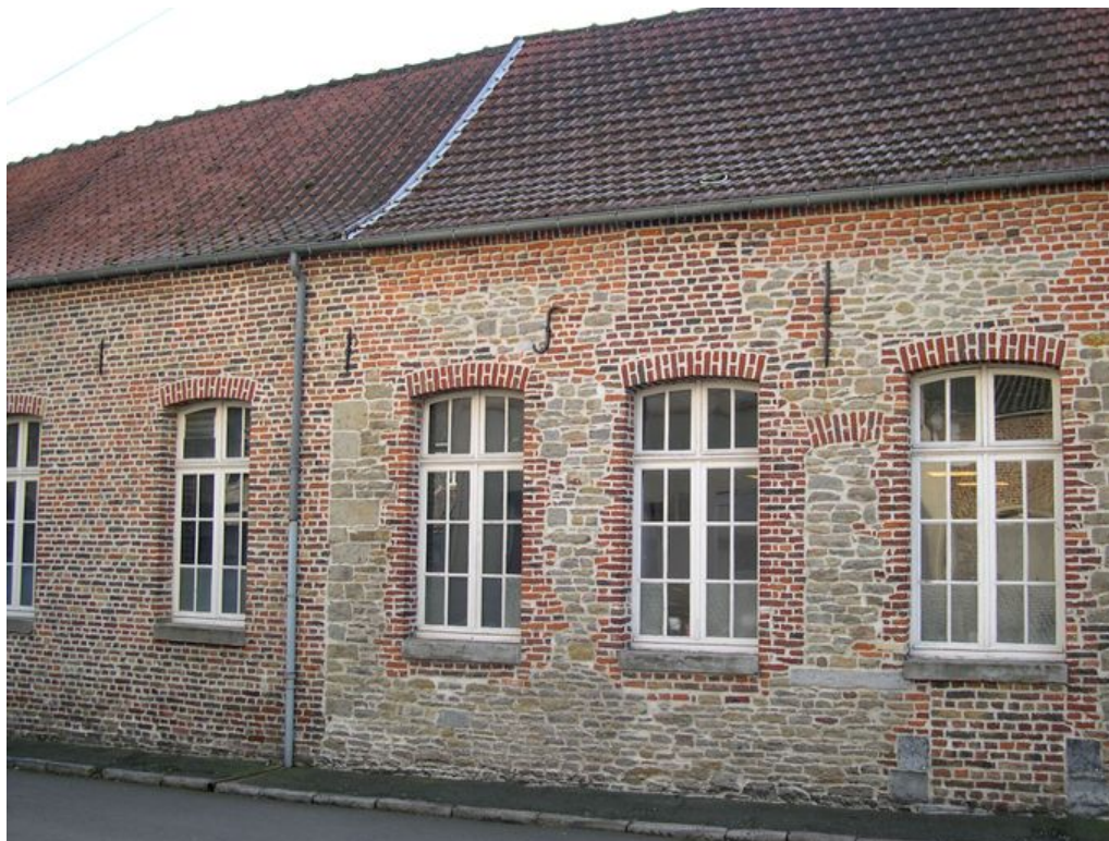
Rue Neuve, école des filles, vue partielle : maçonnerie de pierre calcaire reprise en brique, extension du bâtiment à gauche, en brique.
