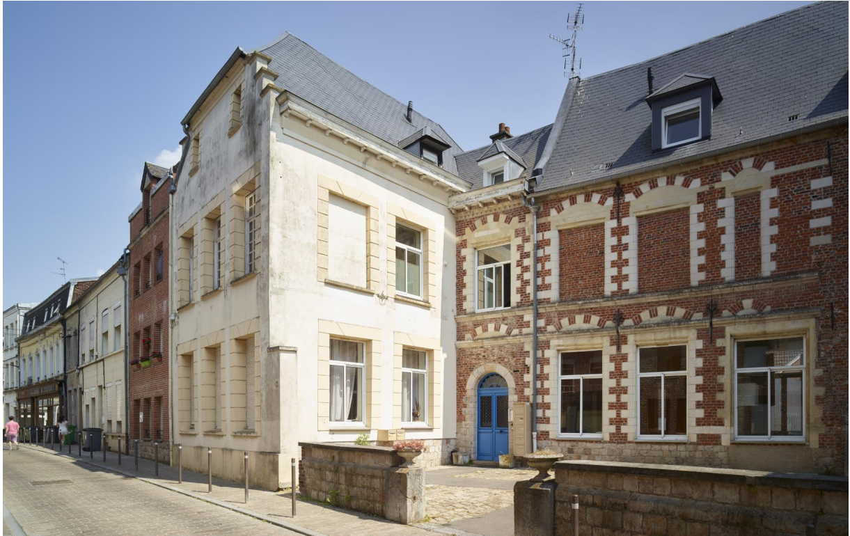
Partie gauche de la façade avant sur la rue Théau et aile en retour d'équerre gauche. Vue orientée nord-est/sud-ouest.
