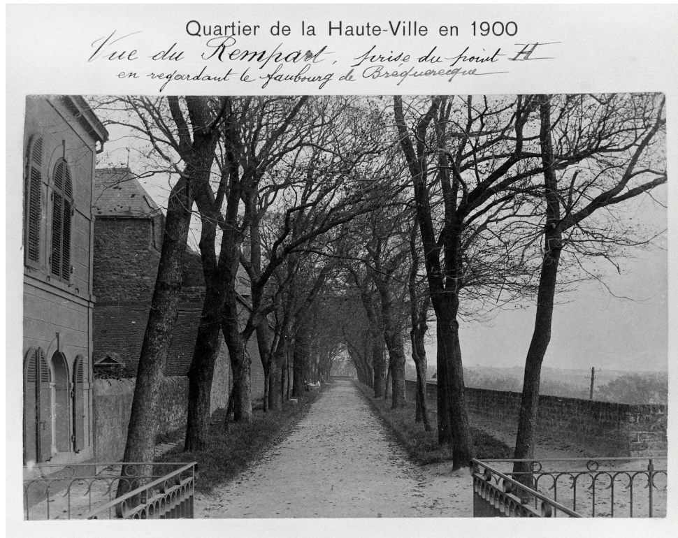
Vue sur rempart vers 1900, carte postale, porte des Degrès vers sud, A.C. Boulogne-sur-Mer, div. cart. post., série rues de Boulogne.
