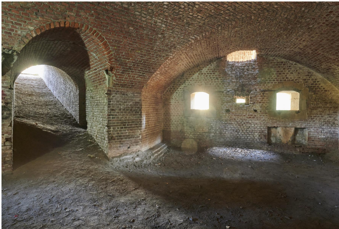
Caponnière double, vue intérieure. À gauche l'accès à la galerie de fusillade.
