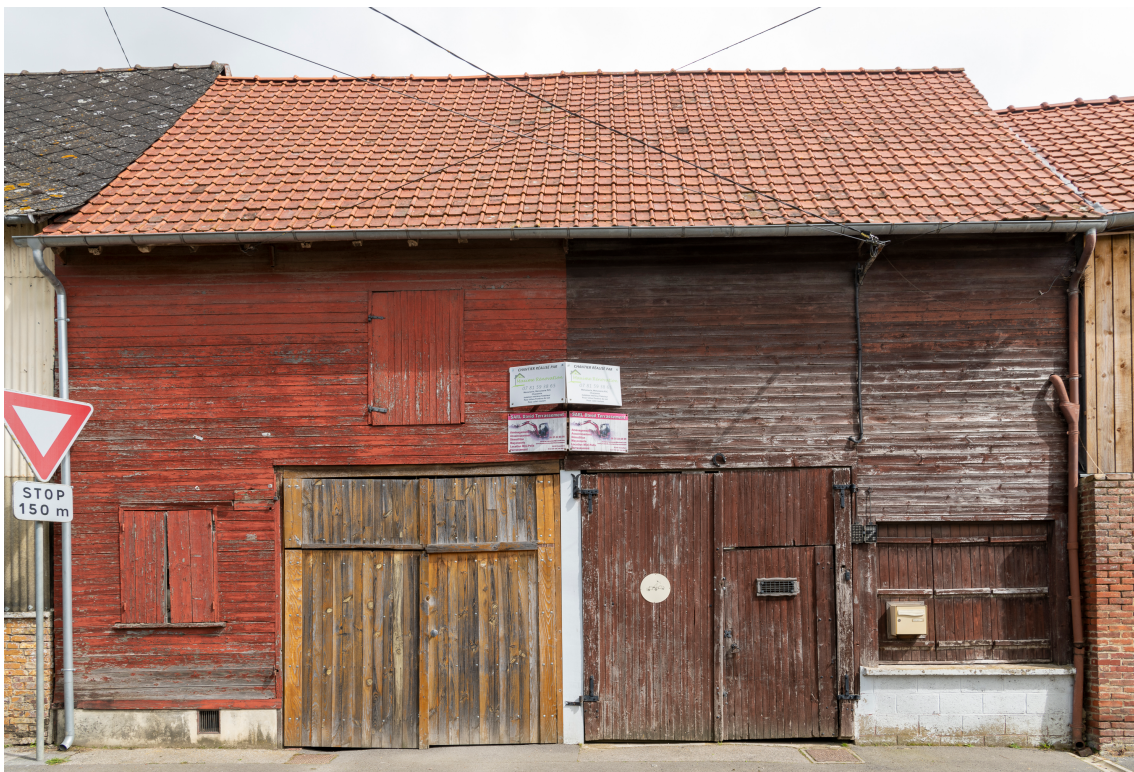
Anciennes "boutiques" sur rue avec entrée charretière, n°5-7 de la rue Lambin, vue depuis le sud.
