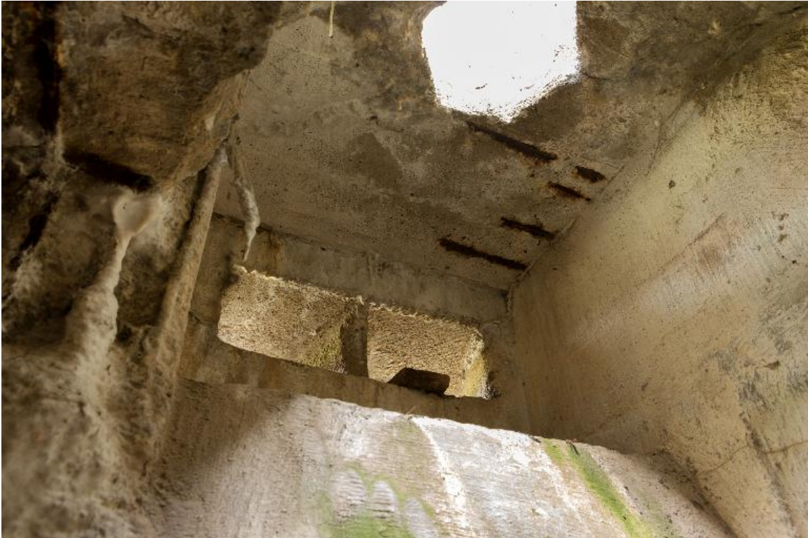
Casemate b. Vue intérieure de l'observatoire bétonné. Passage du périscope et embrasures de surveillance, vers nord-ouest.
