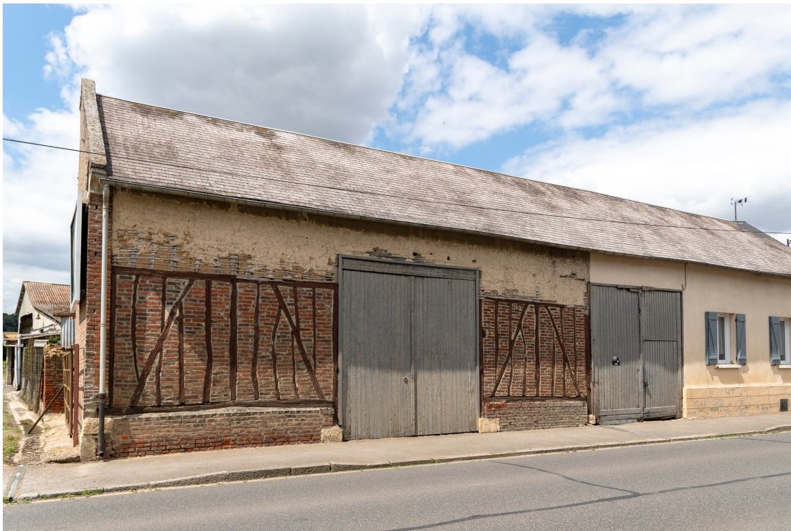
Grange sur la rue prolongée par une entrée charretière et un logis, n°65 de la rue de Beauvais, vue depuis le sud-est.
